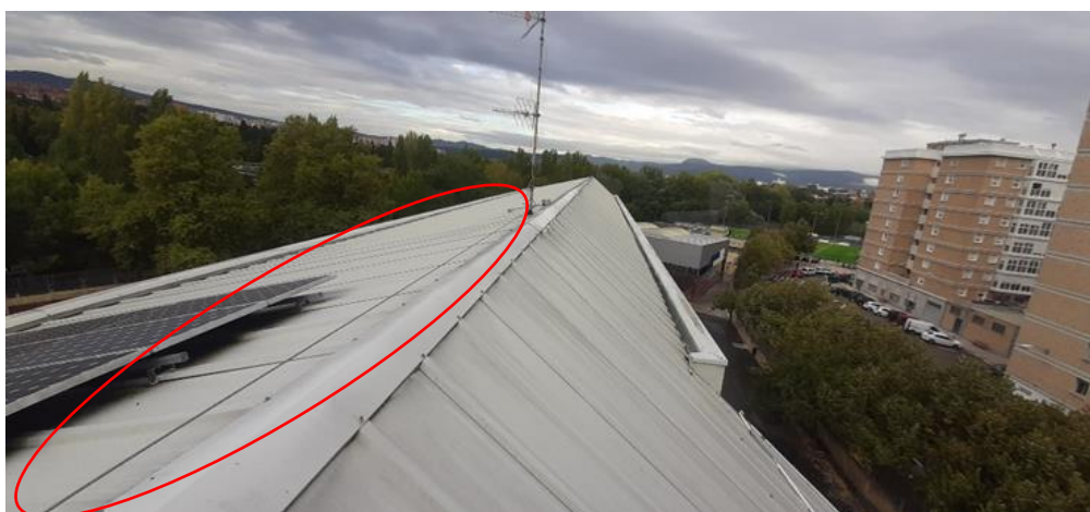
Ilustración 3: Línea de vida existente en el edificio norte
